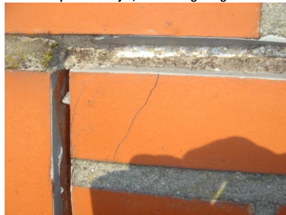
Foto 16: EPS achtergelaten in lintvoeg, dus geen ruimte voor dilatatie en dichtgezet met voegspecie
